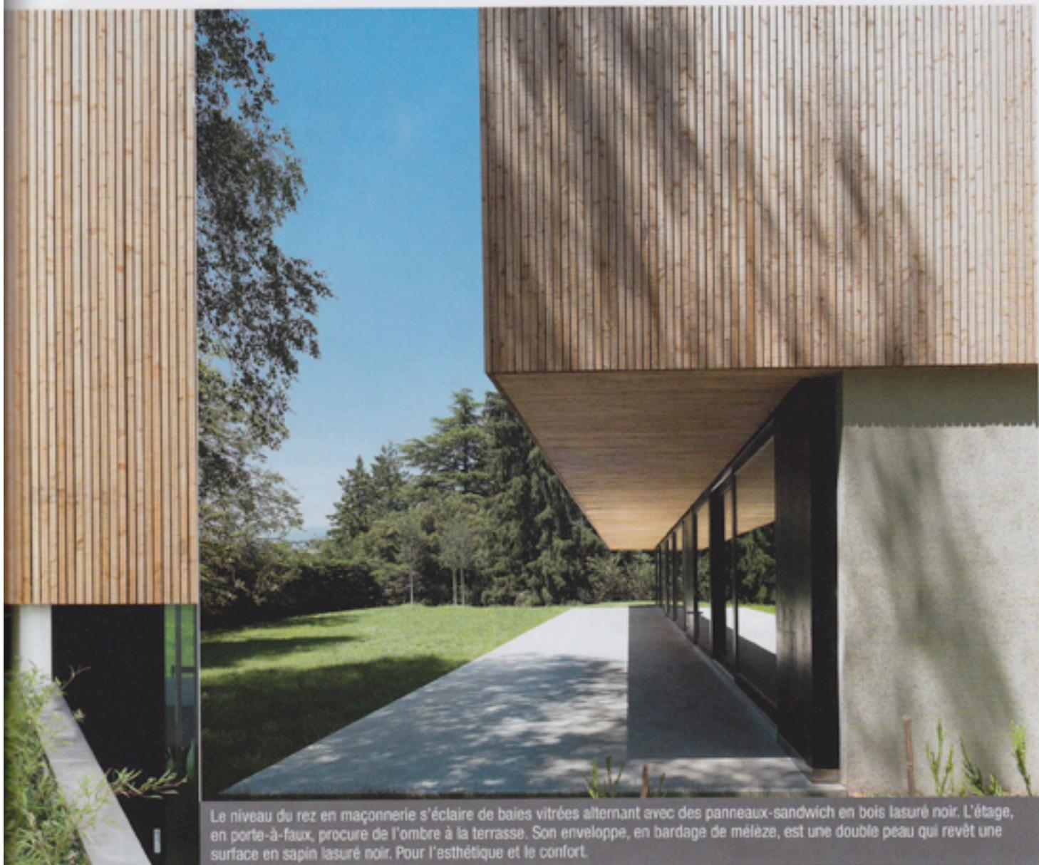
Le niveau du rez en maçonnerie s'éclaire de baies vitrées alternant avec des panneaux-sandwich en bois lasuré noir. L'étage, en porte-à-faux, procure de l'ombre à la terrasse. Son enveloppe, en bardage de mélèze, est une double peau qui revêt une surface en sapin lasuré noir. Pour l'esthétique et le confort.
