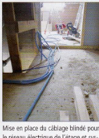
Mise en place du câblage blindé pour le réseau électrique de l'étage et système de coupure de champ pour réduire les nuisances des champs électromagnétiques.
