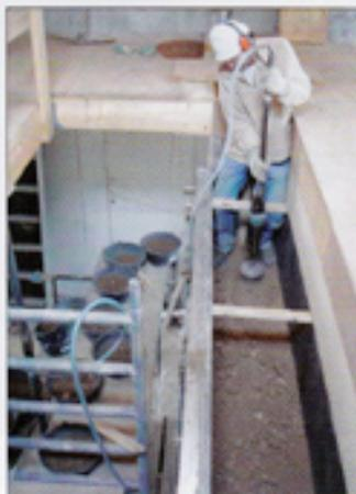
Pascal Favre (Arbio) à l'oeuvre du pisé avec un fouloir automatique à air comprimé.
