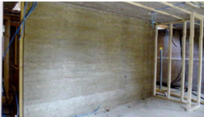
La chambre parents: les murs en pisé restent apparents. Ces murs porteurs en "béton de terre" ont une très grande capacité de réguler passivement l'hygrométrie et la température d'un lieu tout en faisant office de masse thermique très intéressante.
