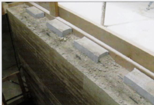
Trois semaines après que le pisé soit terminé (et donc sec), mise en place de plots à hauteur de la poutraison en bois pour la mise en charge du pisé au moyen de tiges filetées.
