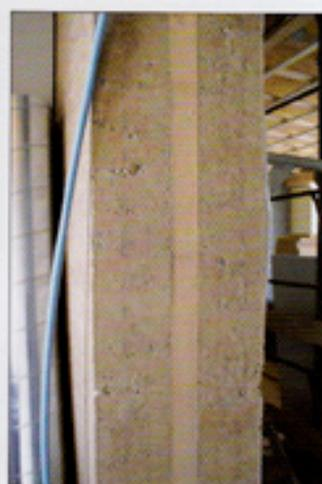
Le pisé a été préalablement stabilisé avec de la chaux. Compte tenu que les murs sont bruts de décoffrage, cette solution permet d'obtenir des surfaces très dures (ou moins friables) ainsi que des angles vifs.
