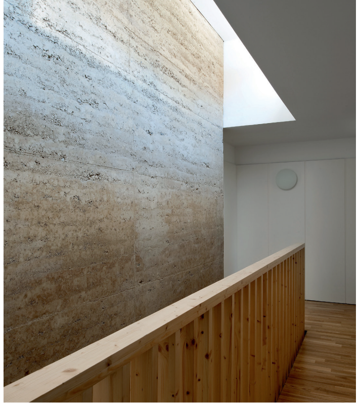
Le lanterneau central avec le mur en pisé
