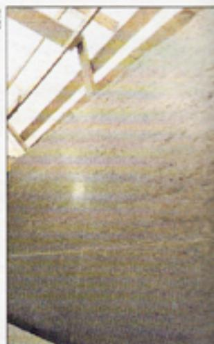
Le mur intérieur en pisé sert de régulateur naturel de température.
